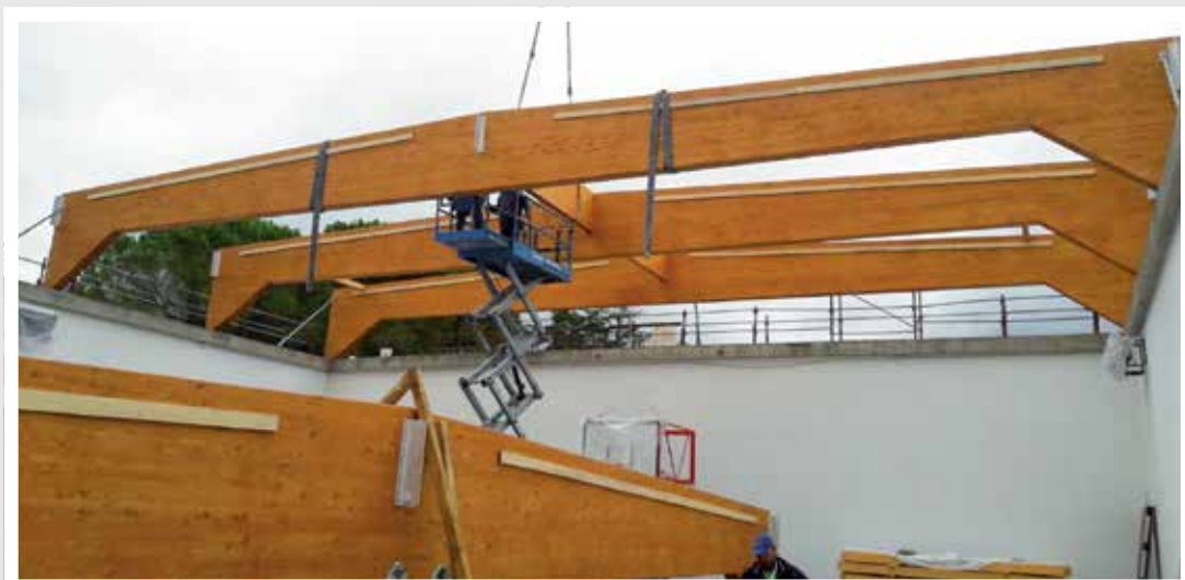
1° stralcio di miglioramento sismico Centro Sportivo di Santo Marino.
