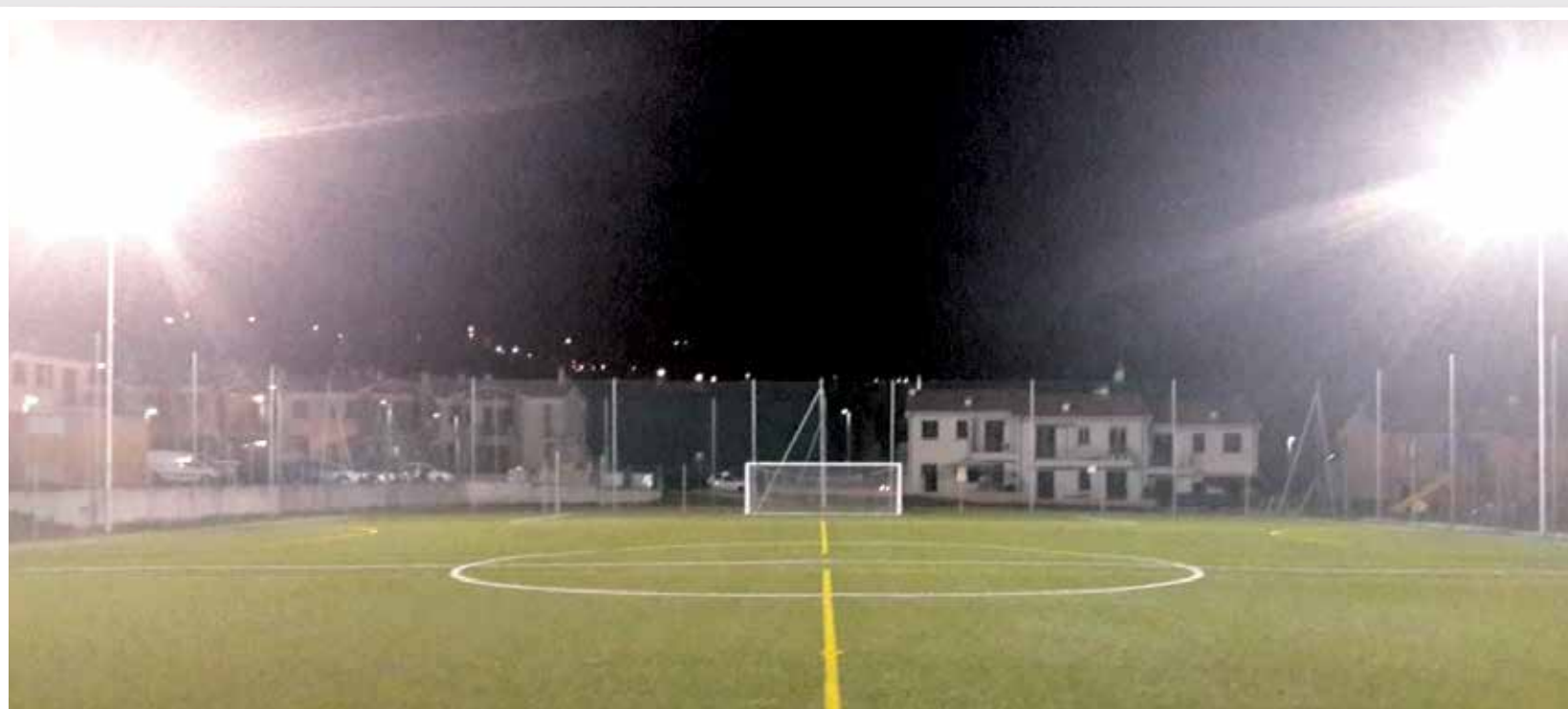
Nuovo impianto d'illuminazione.
