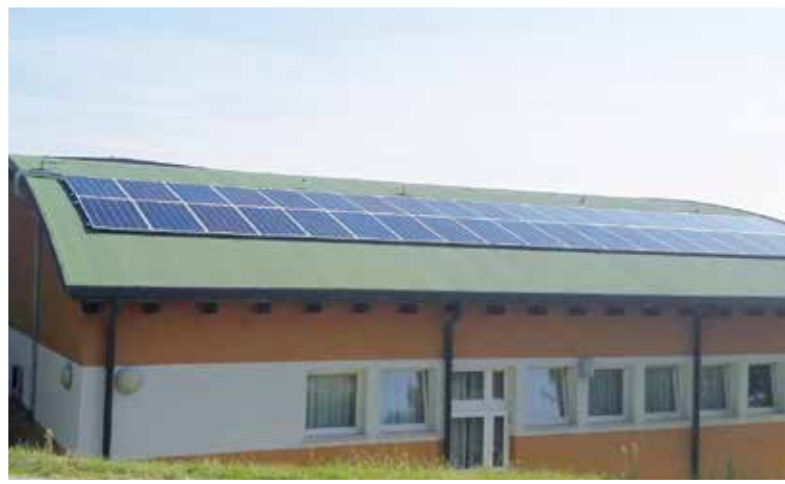
Impianto fotovoltaico centro sociale di Santo Marino.
