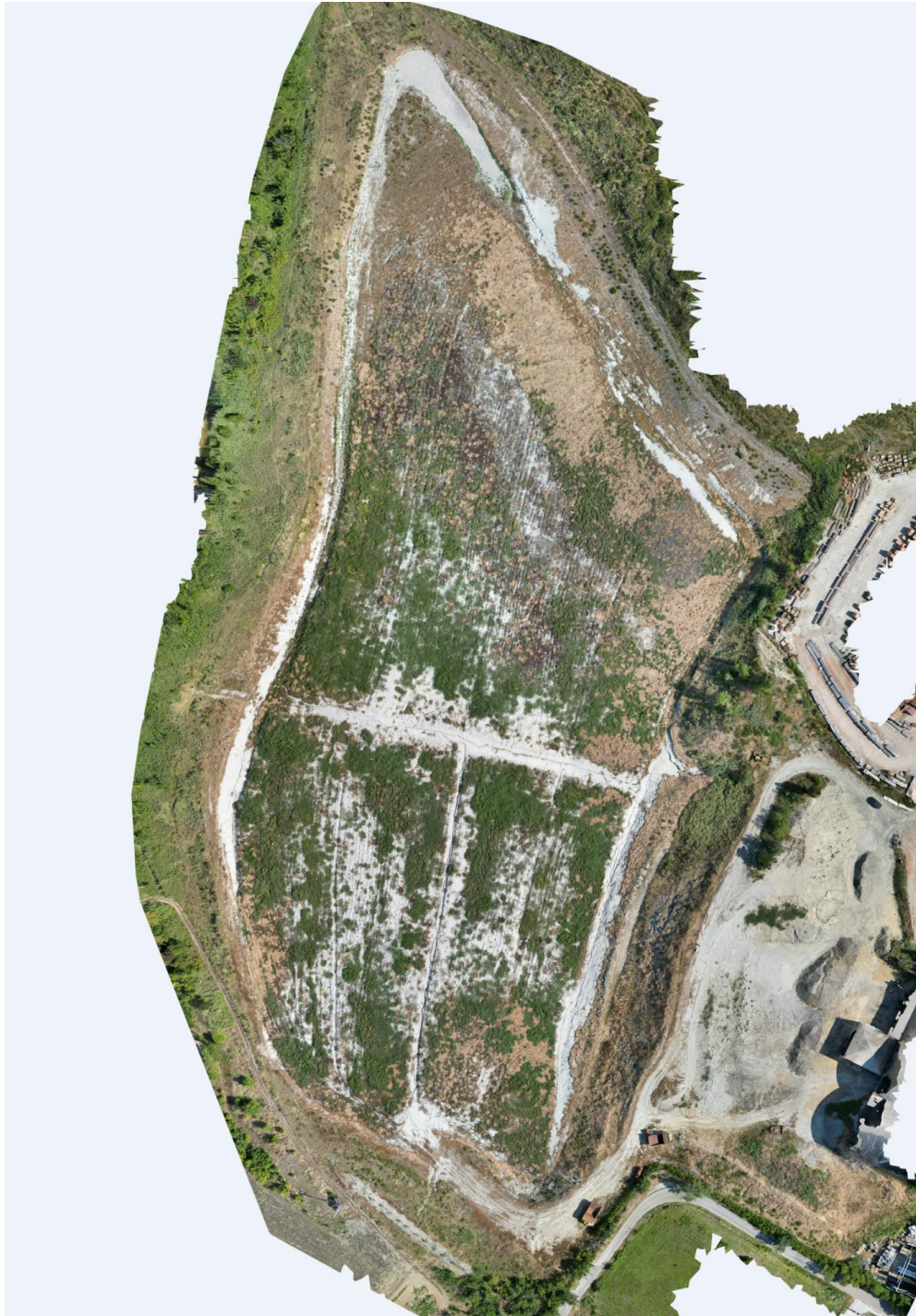
Foto 6 – ortofoto realizzata con drone nell’agosto del 2024. Le direttrici di scolo esistenti e realizzate in passato (ben visibili in foto) verranno mantenute al fine di garantire la corretta regimazione idrica all’interno del sito.
