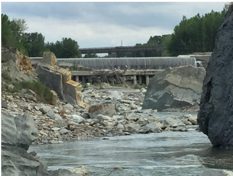
Foto 3-2.5 progressione erosiva in alveo del F. Marecchia fino alla briglia del Consorzio di Bonifica con rimozione del substrato formazionale anche attorno ai pali di fondazione.
