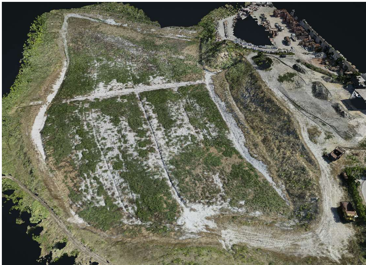
Foto 1 – panoramica dell'area di intervento – ortofoto 3D dell'agosto 2024
