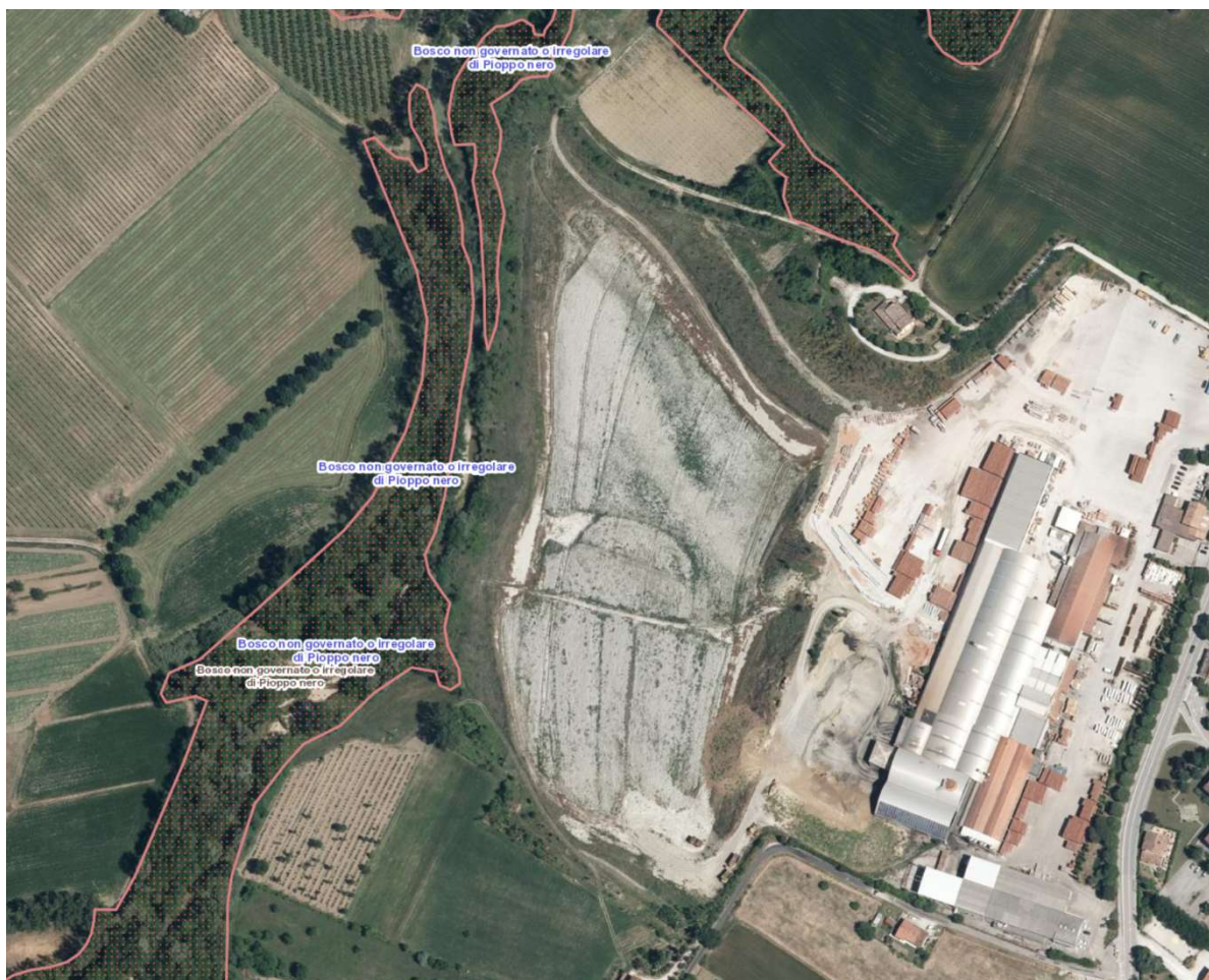
Fig. 4 – carta forestale regionale. Si evidenzia la pressochè totale assenza di copertura vegetazionale nell’areale di cava. Ai margini esterni e mai internamente alla zona, sono presenti boschi non governati di pioppo nero (ambito fluviale).
